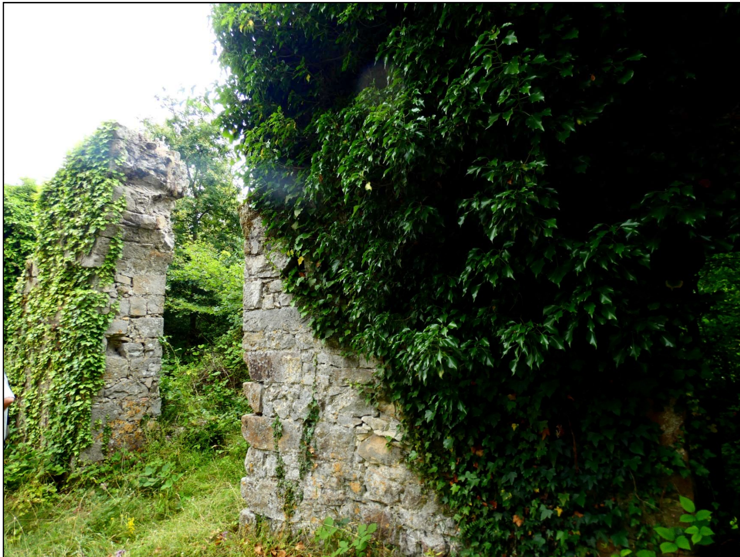
Ci-dessus : Vue du mur sud de la chapelle Sainte-Marguerite
