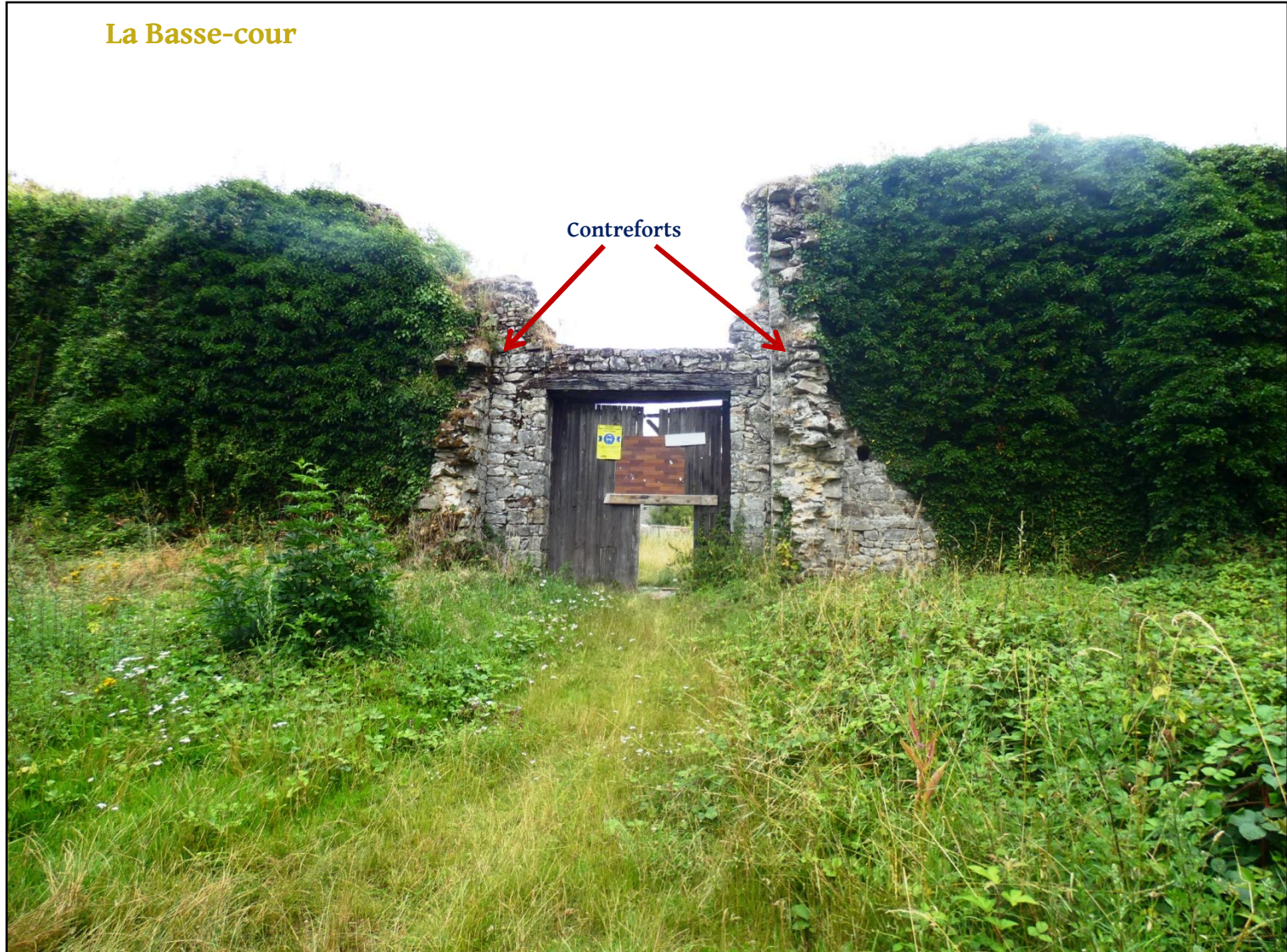
Ci-dessus : Vue de l'entrée de la basse-cour du château de Montaiguillon. Elle est encadrée par deux puissants contreforts de pierre
