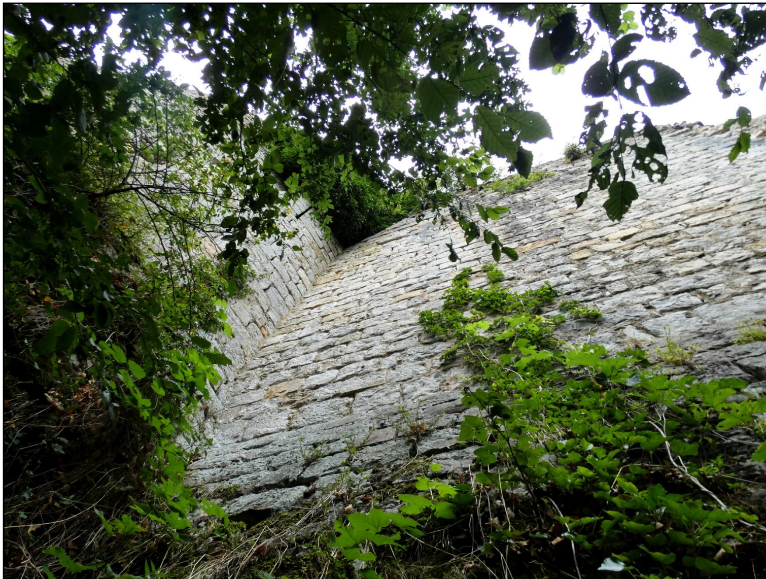
Ci-dessus : vue de la courtine voisinant avec la tour sud du châtelet d'entrée
