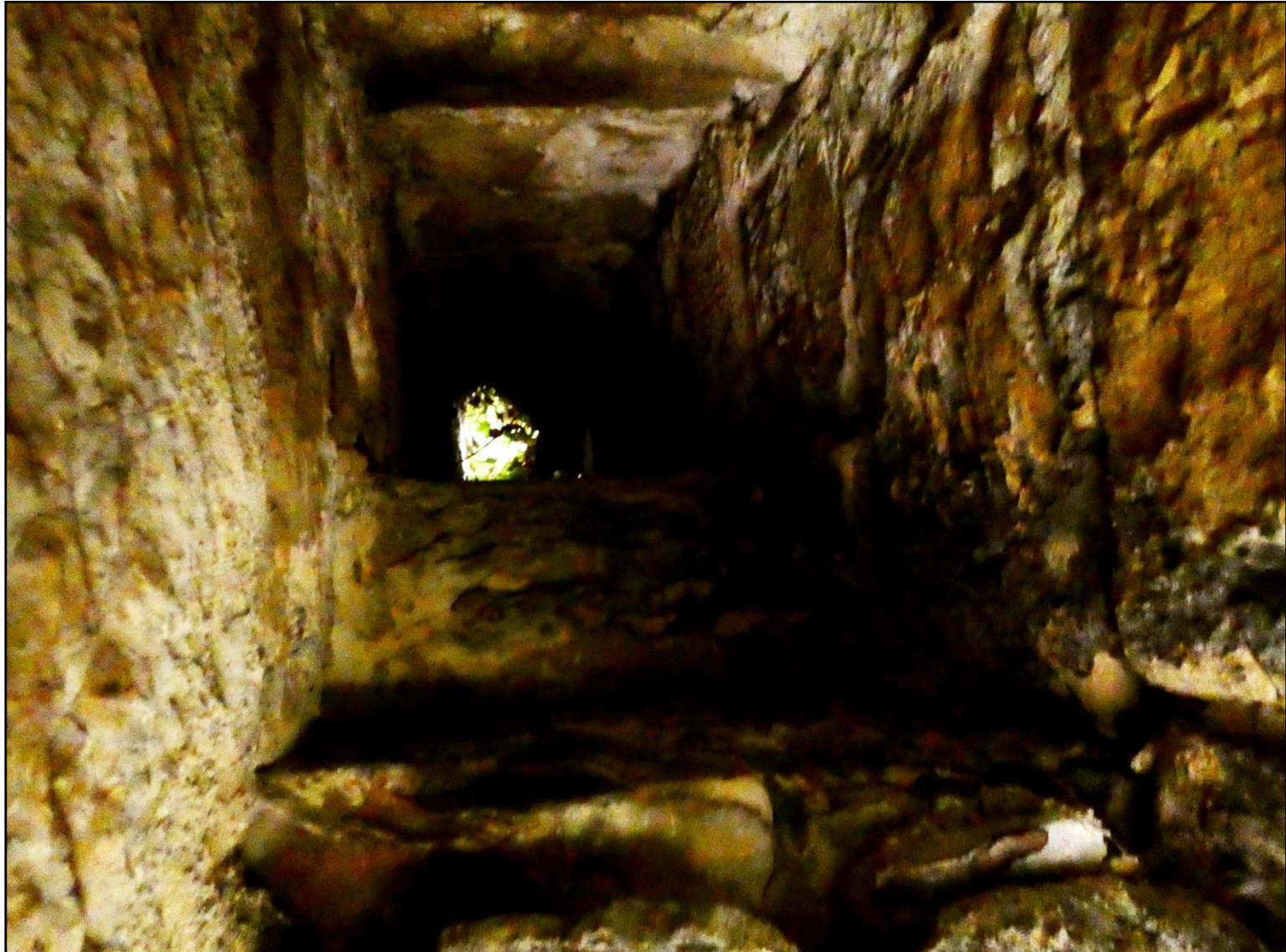
Ci-dessus : Intérieur probable d'un conduit de cheminée ?
