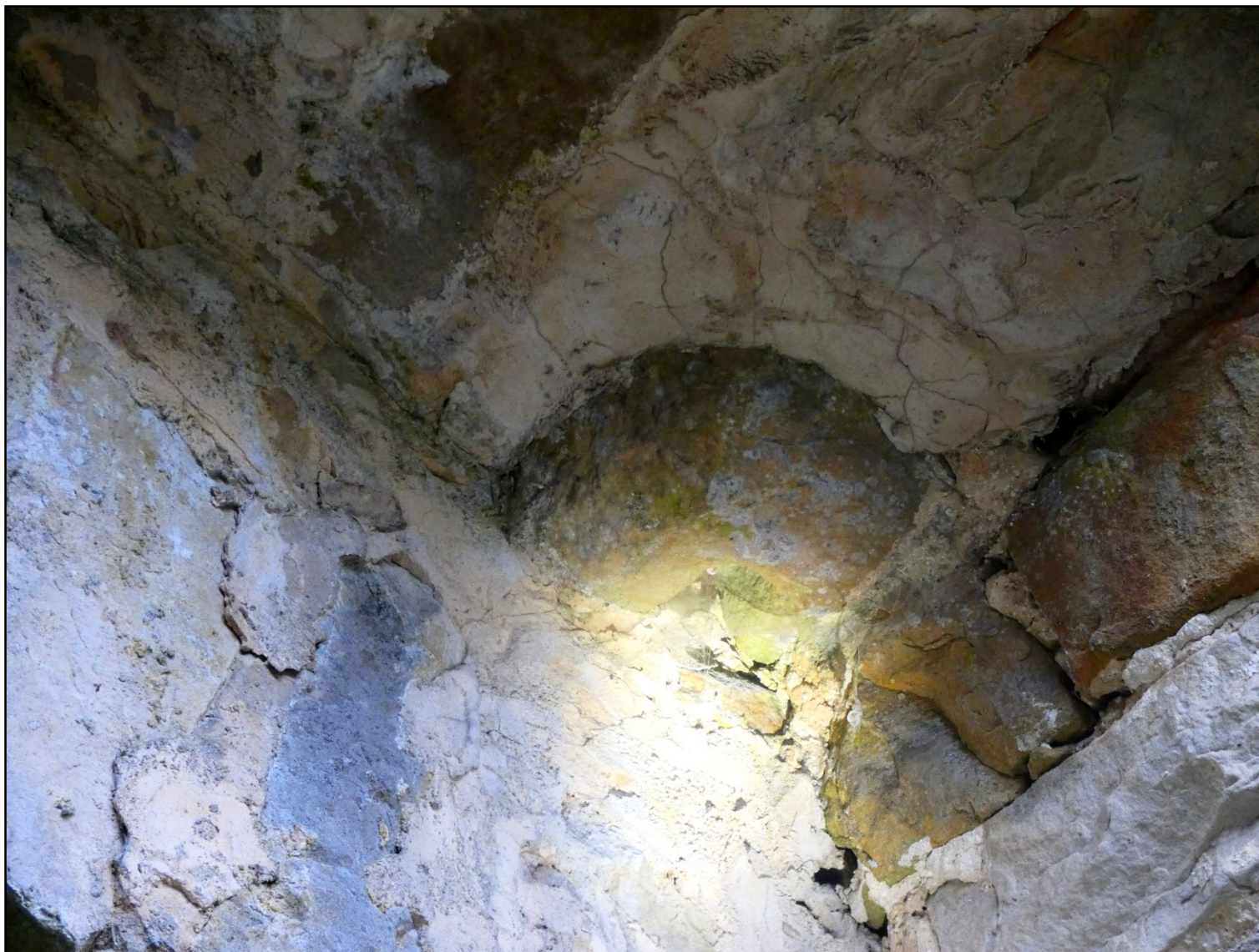
Ci-dessus : Vue d'une pierre dont l'encoche emprisonnait l'un des gonds métalliques des portes de la chapelle
