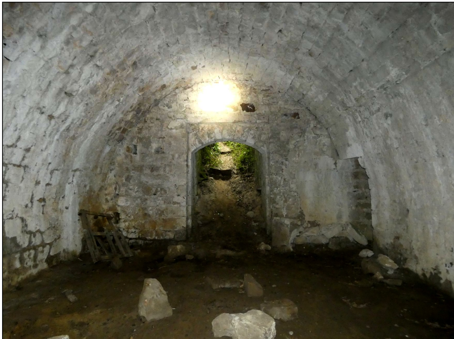
Ci-dessus : Vue de la première salle souterraine de Montaiguillon, avec sa spectaculaire voûte en berceau
