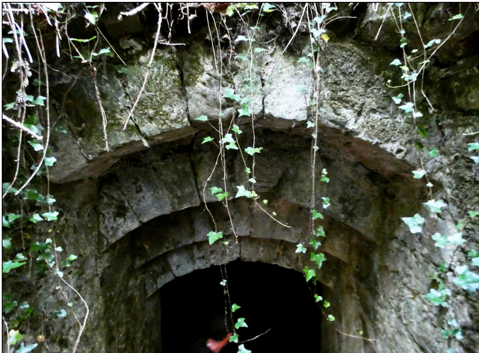
Ci-dessus : Accès à l'une des salles souterraines de Montaiguillon
