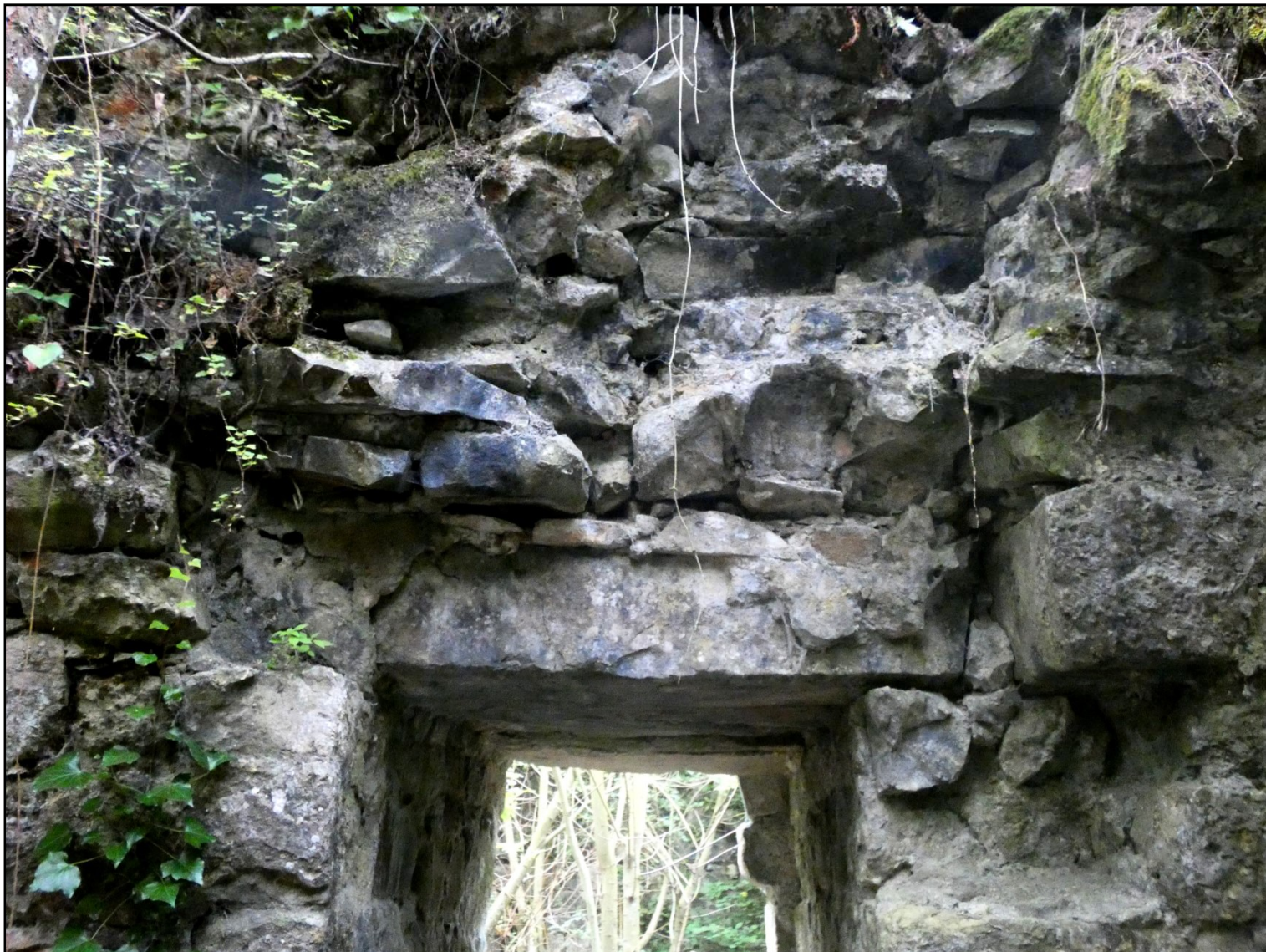
Ci-dessus : Vue d'un passage surmonté de lourds blocs de grès
