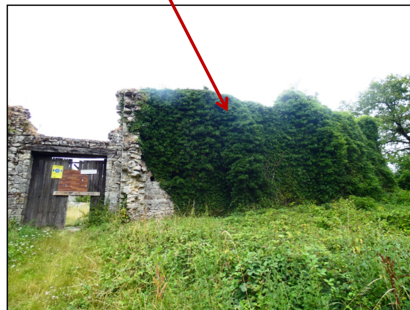
Ci-dessus : vue du mur sud-ouest de la basse-cour
