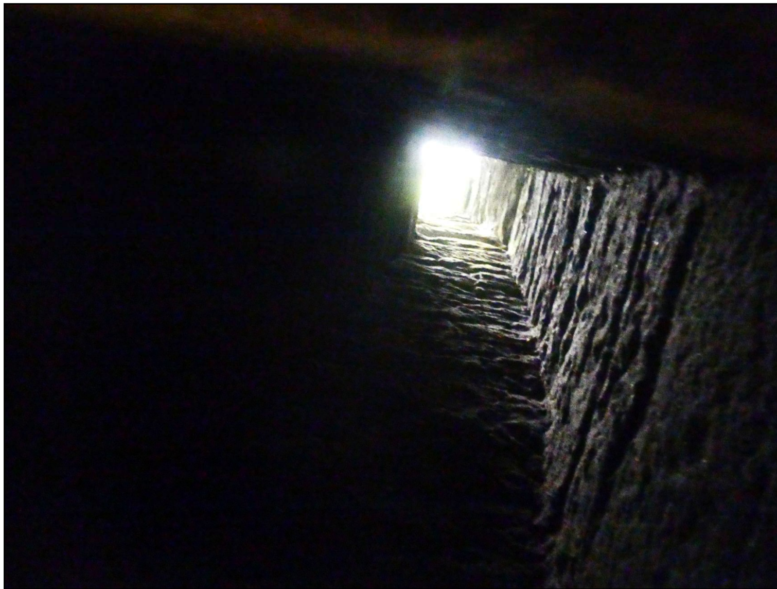
Ci-dessus : conduite d'aération visible dans la seconde salle souterraine
