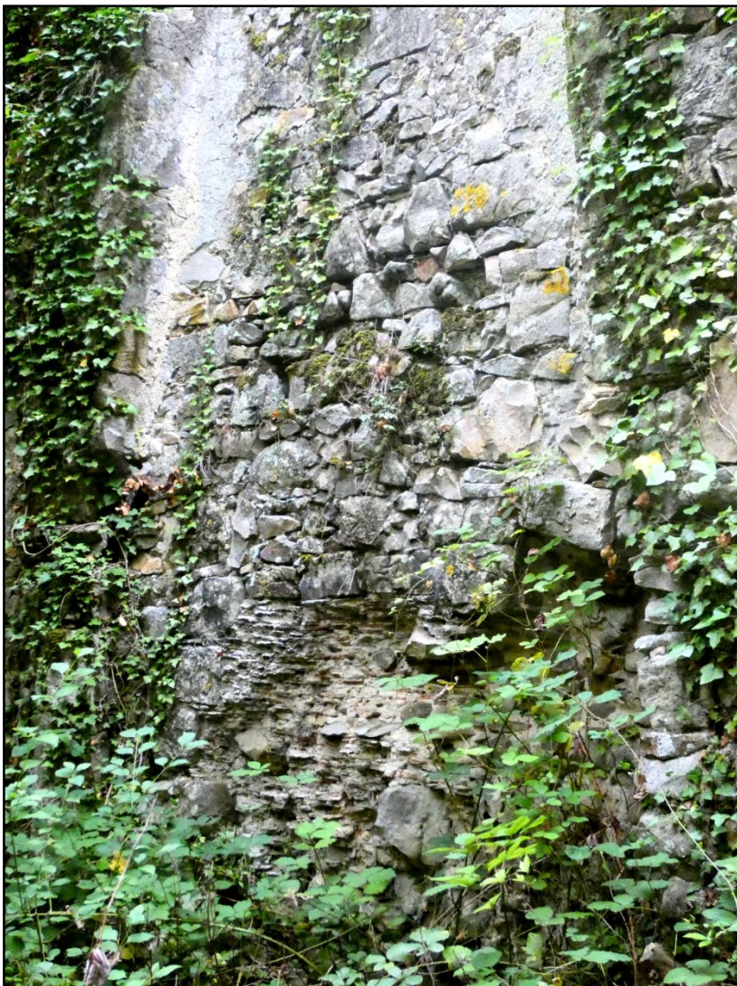
Ci-dessus : vue des vestiges de la cheminée du rez-de-chaussée
