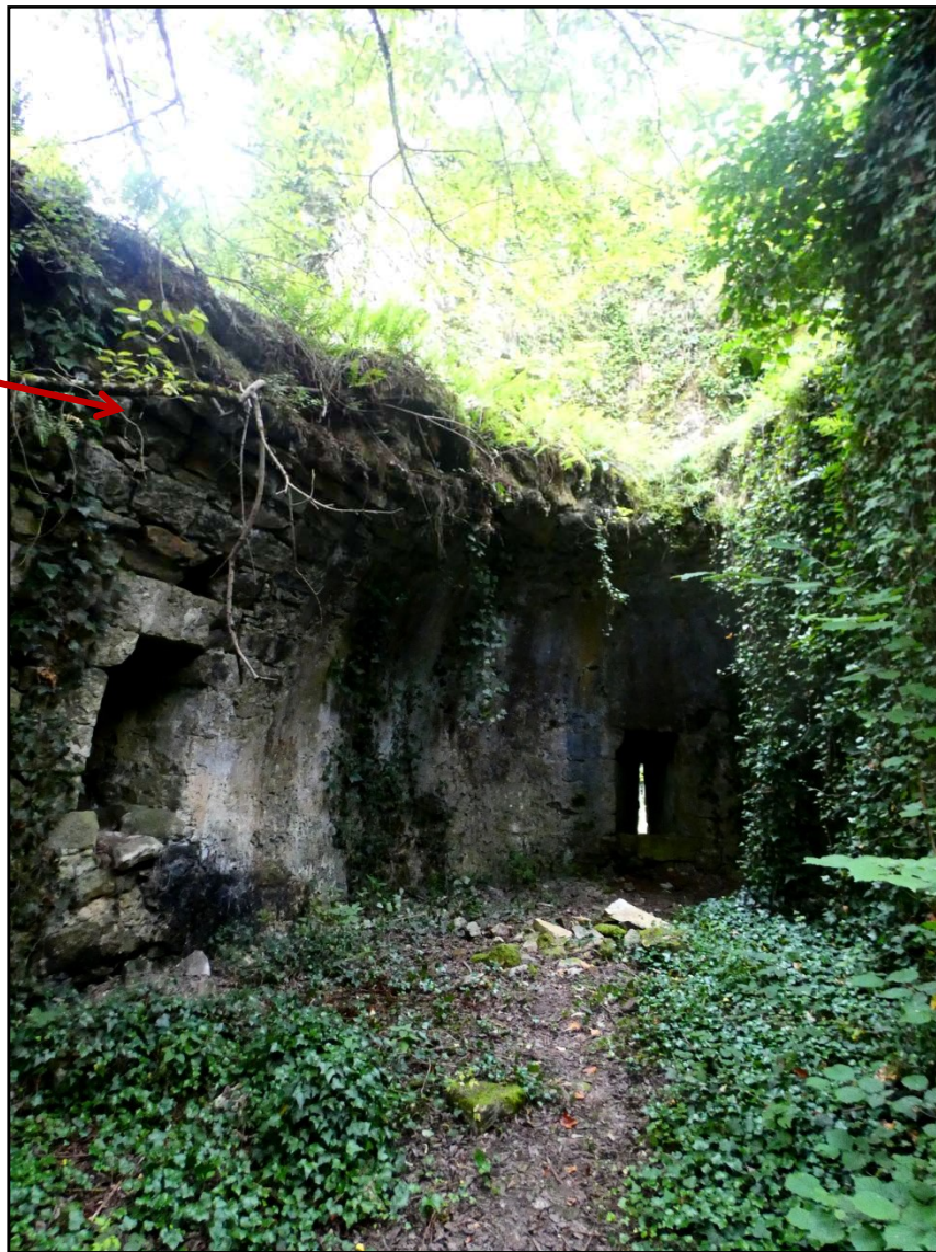
Ci-dessus : vue intérieure de la tour nord du châteleet d'entrée. L'on voit tout au fond, l'ouverture donnant accès à une archère
