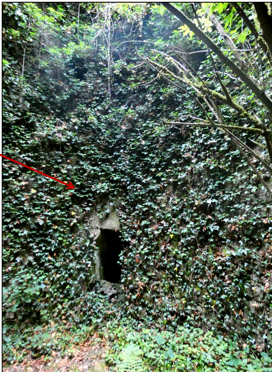
Ci-dessus : Élévation de la tour d'angle nord-ouest
