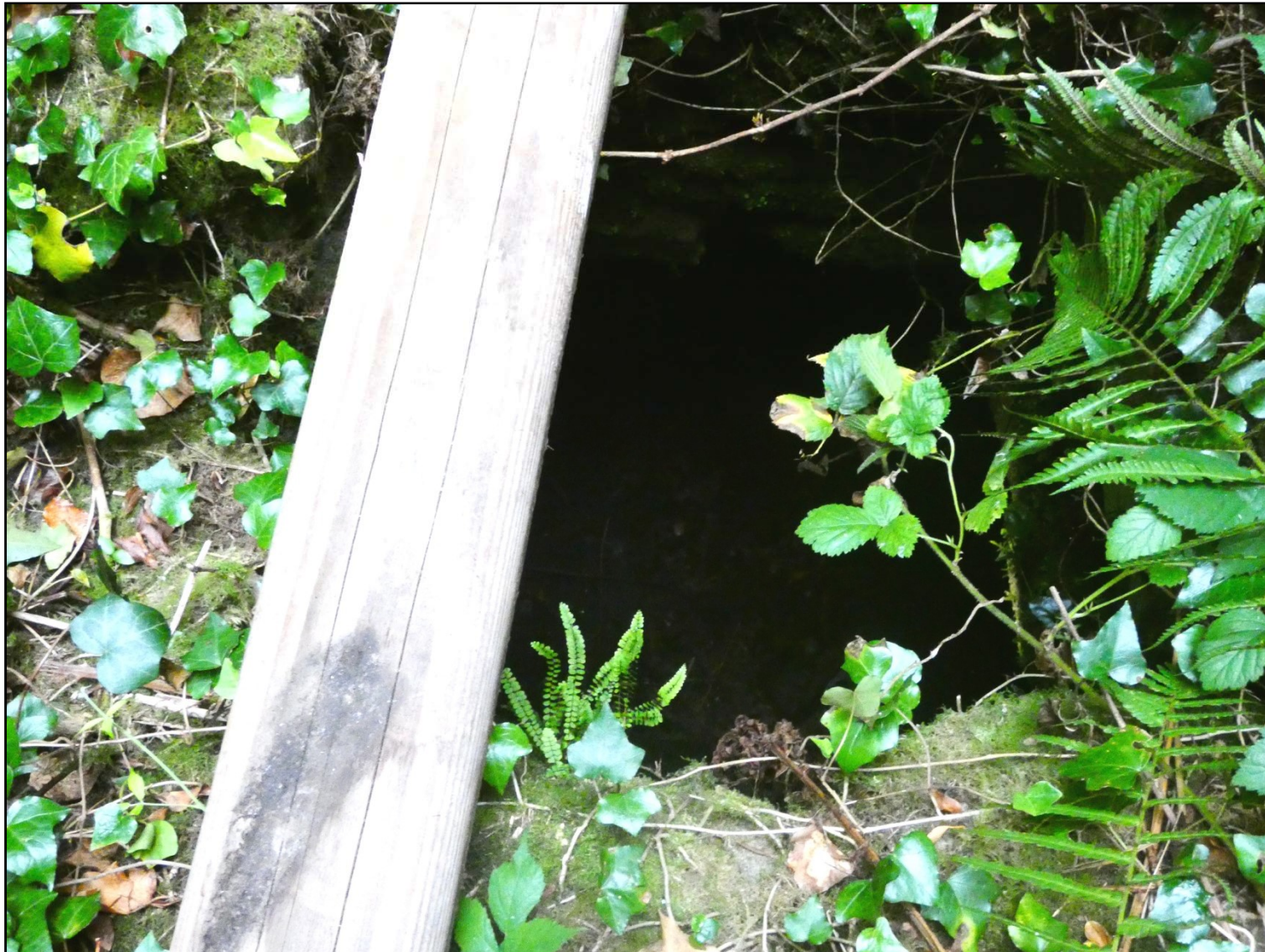
Ci-dessus : Vue de la citerne située sous la tour d'angle nord-ouest
