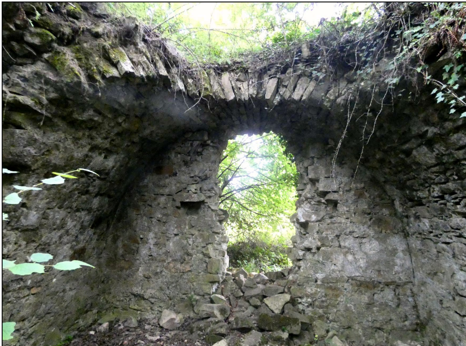
Ci-dessus : Détail de la voûte couvrant le « corps de garde »
