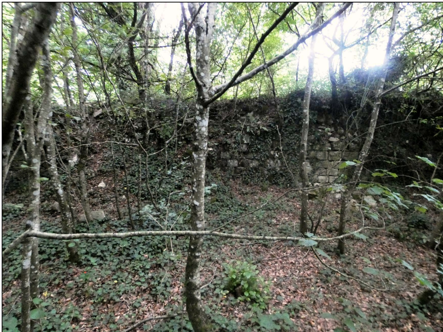
Ci-dessus : sur ce cliché, l'on peut constater avec quel soin a été appareillé le mur du fossé sec entourant le site de Montaiguillon
