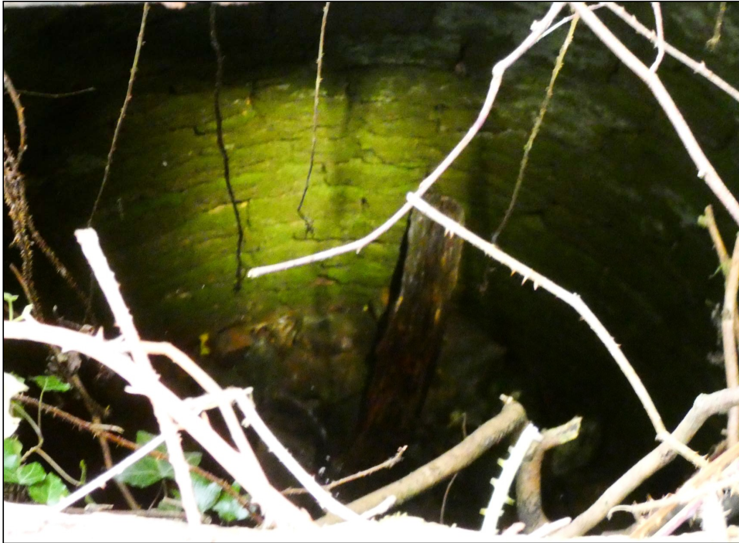
Ci-dessus : Vue du parement intérieur du puits situé dans la cour intérieure du château de Montaignillon
