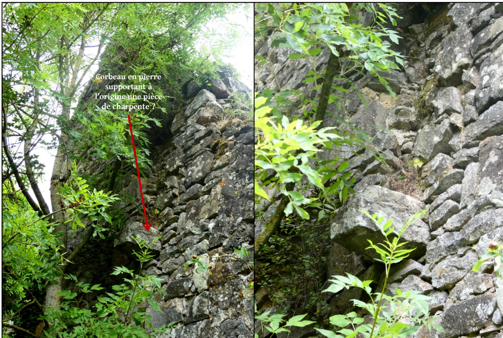
Ci-dessus : Vue d'une partie de la façade ouest
