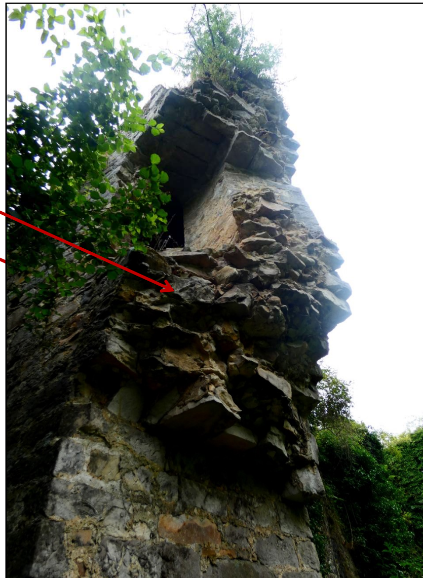
Ci-dessus : vestige de l'escalier de la demi-tour nord
