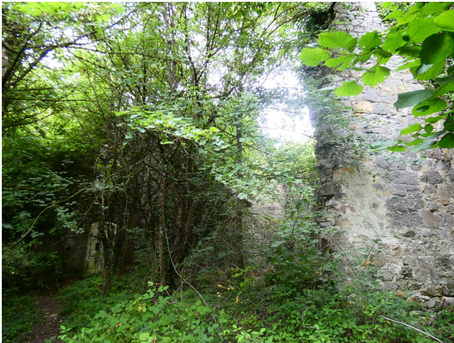
Ci-dessus : vue d'un des murs du corps de logis annexe de celui du gouverneur
