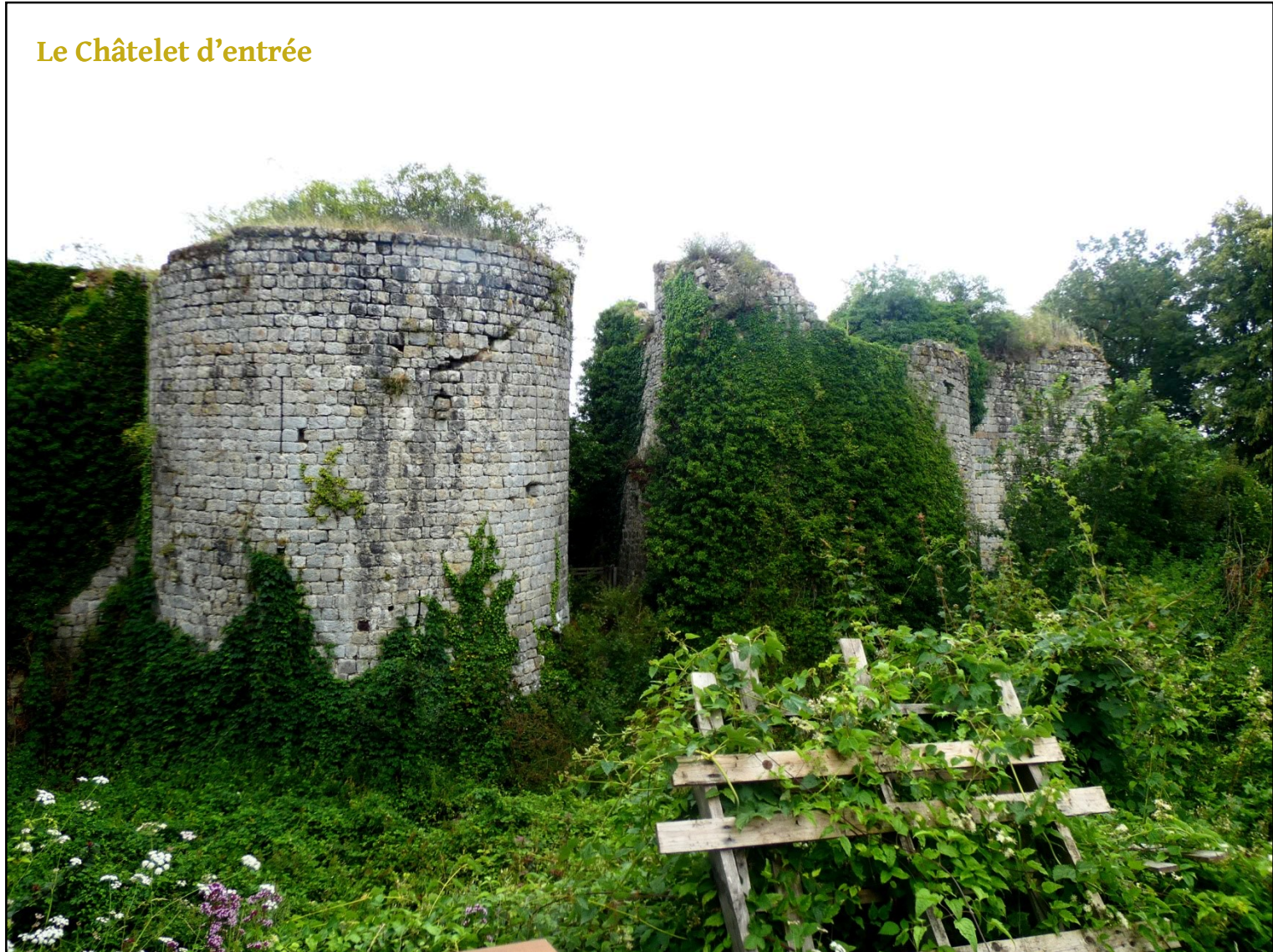
Ci-dessus : autre vue des tours nord et sud du châtelet d'entrée
