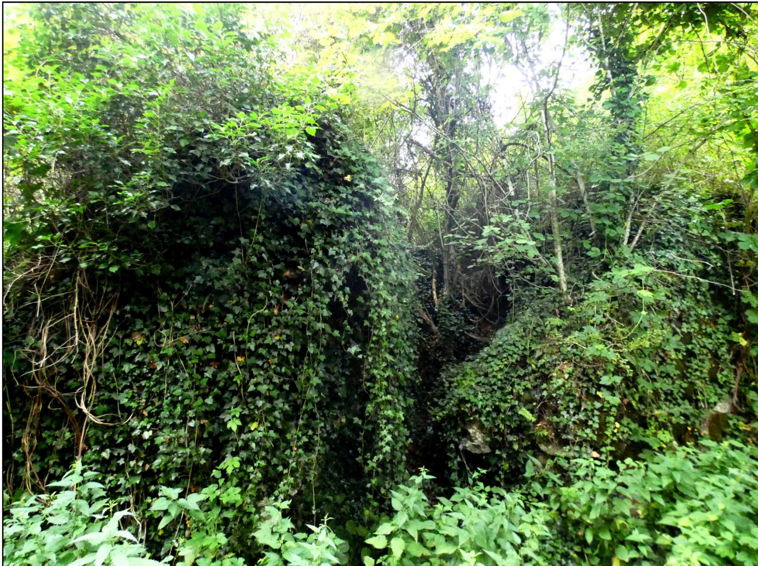
Ci-dessus : Vestiges de la courtine sud (?) de la forteresse de Montaiguillon
