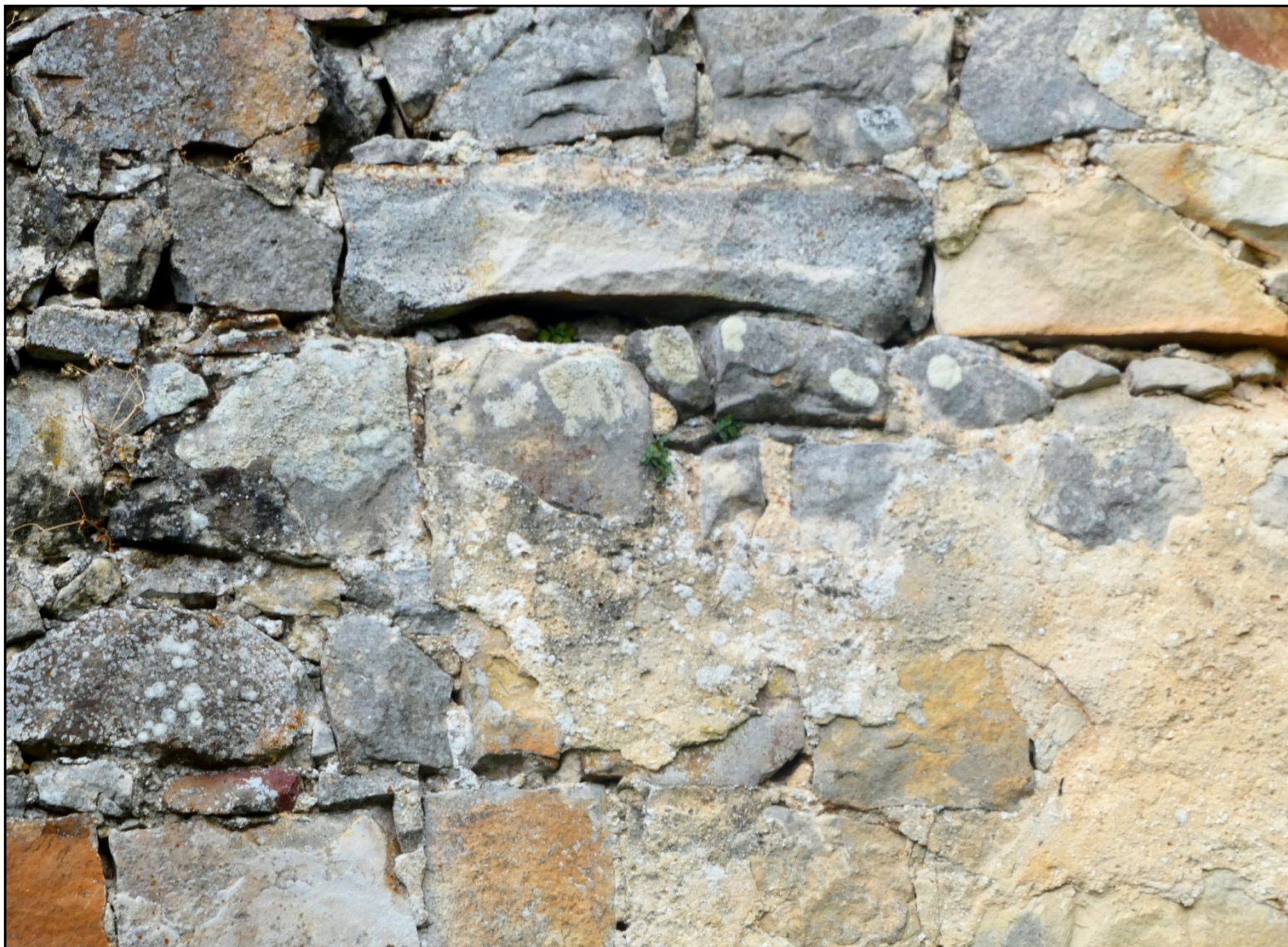
Ci-dessus : Détail du parement de la façade ouest
