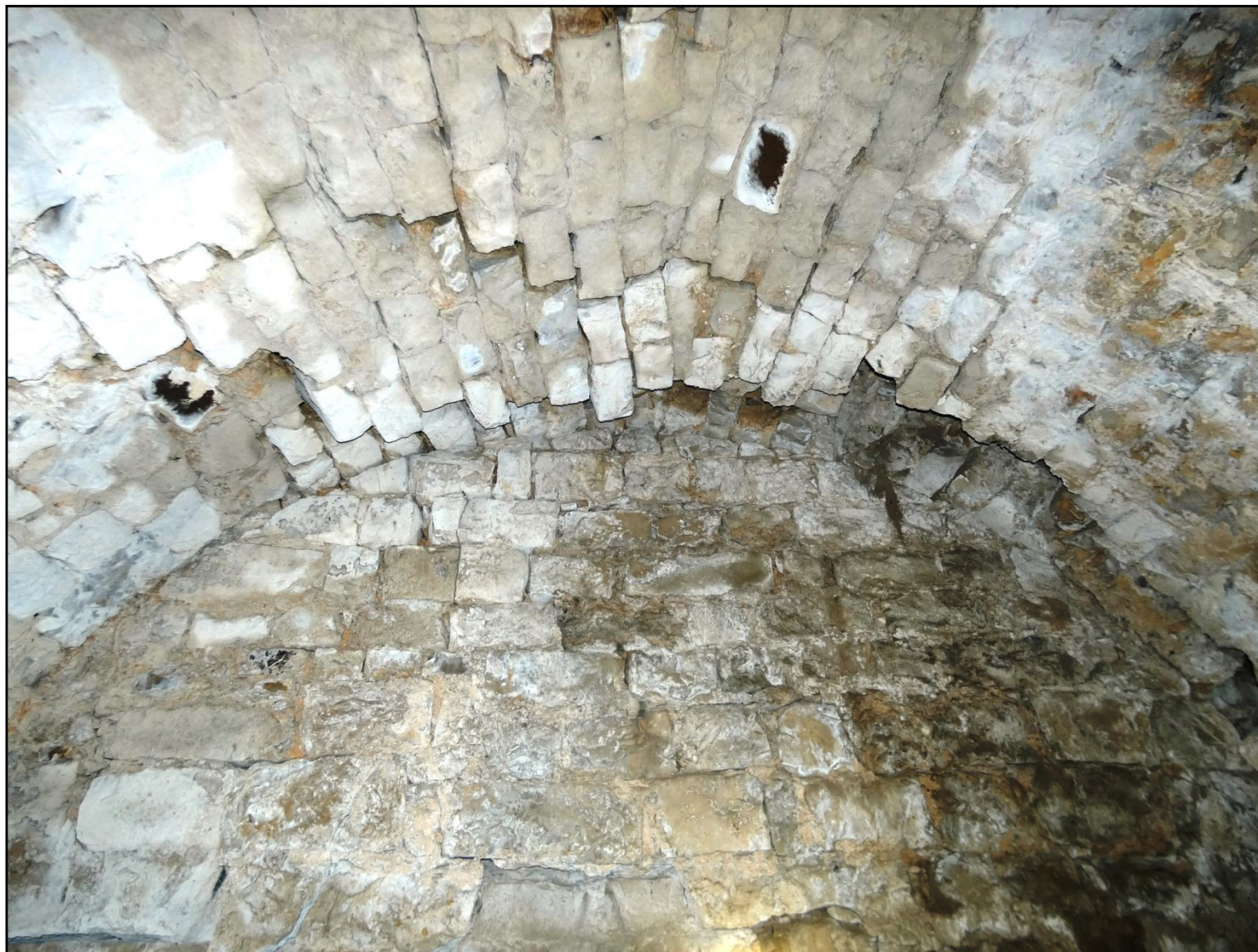
Ci-dessus : détail de l'appareillage de la voûte en berceau
