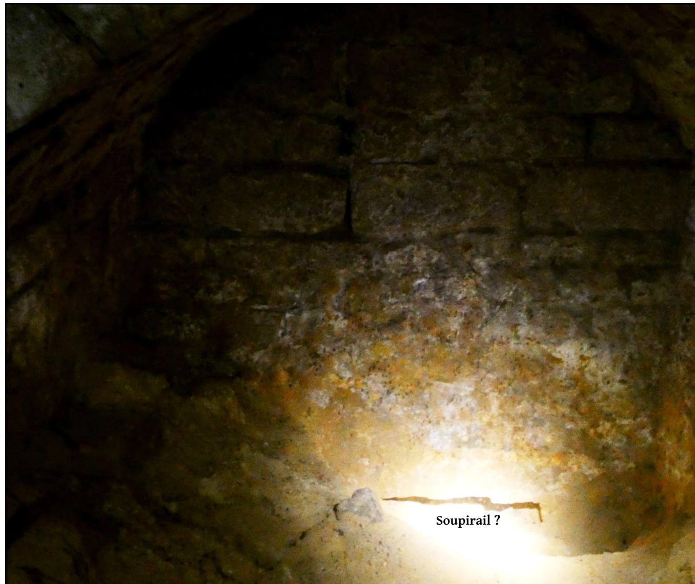
Ci-dessus : Détail du parement de cette première «alvéole » ou caveau annexe
