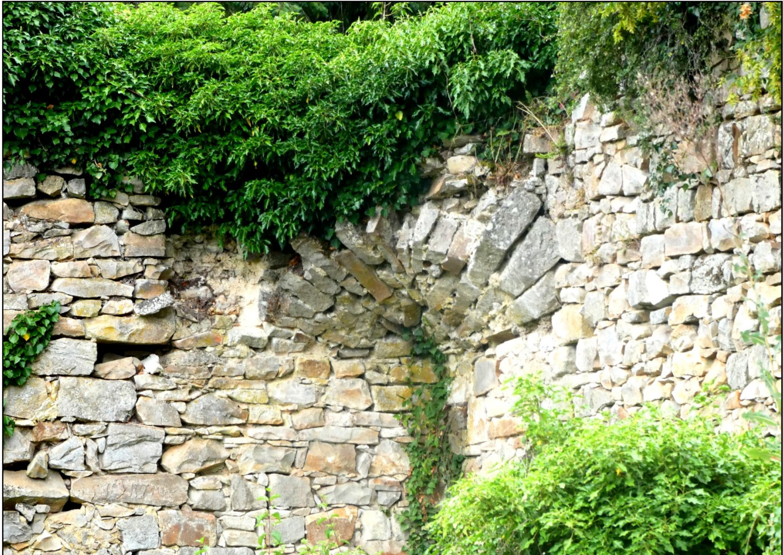
Ci-dessus : détail de la trompe, petite voûte tronquée établie en porte à faux à l'angle d'une construction
