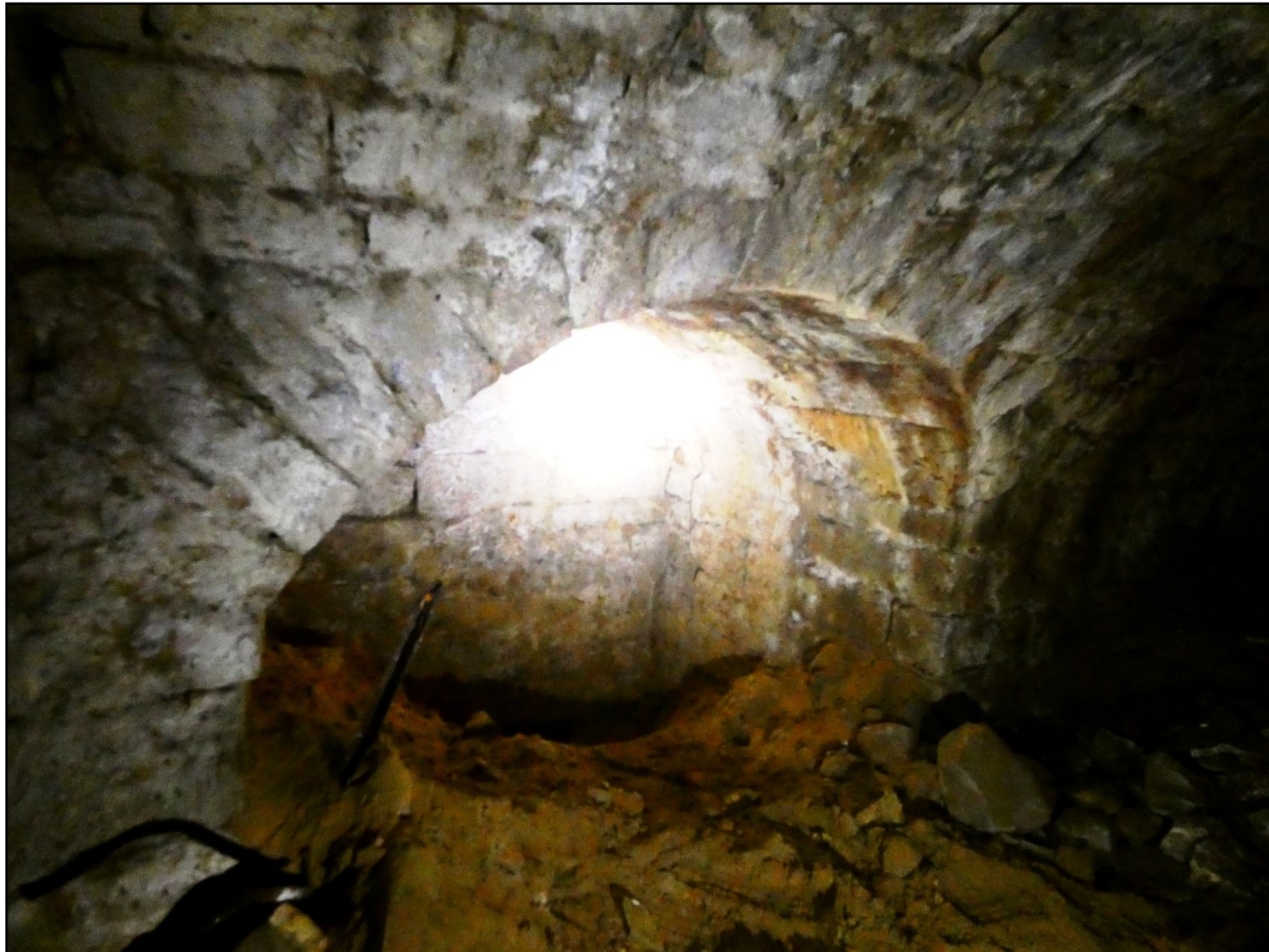
Ci-dessus : côté gauche de la seconde salle souterraine. Y est aménagée une première «alvéole » ou caveau annexe
