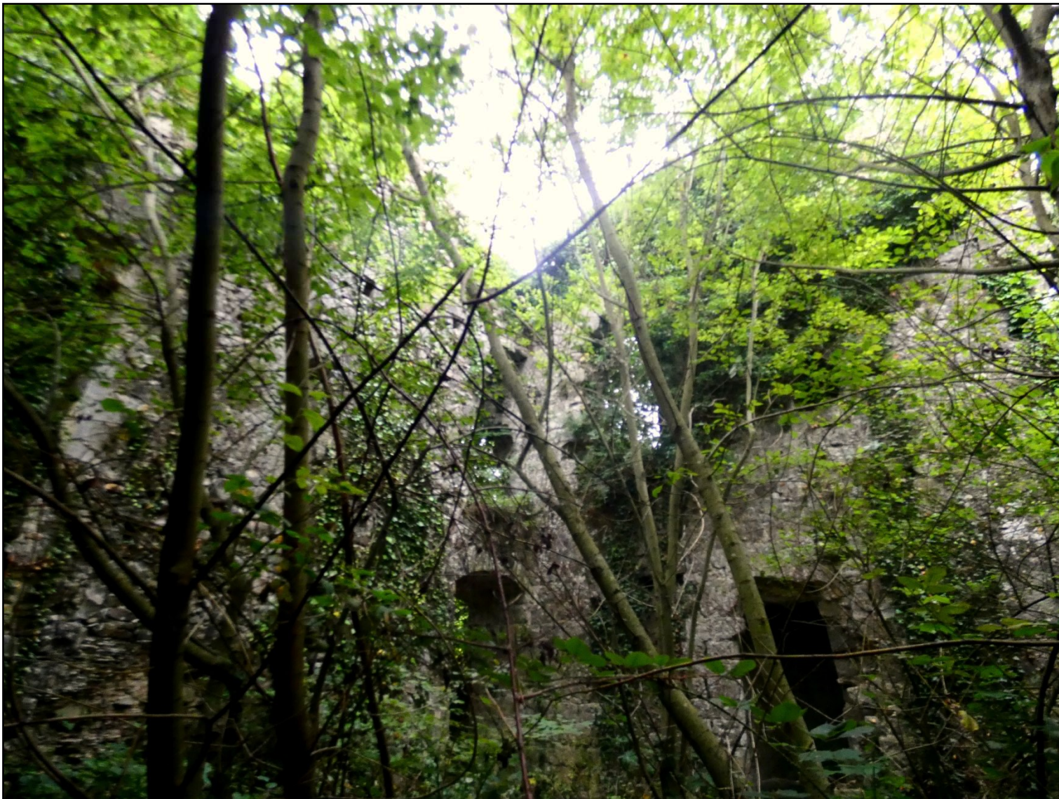
Ci-dessus : mur ouest et nord du corps de logis du gouverneur
