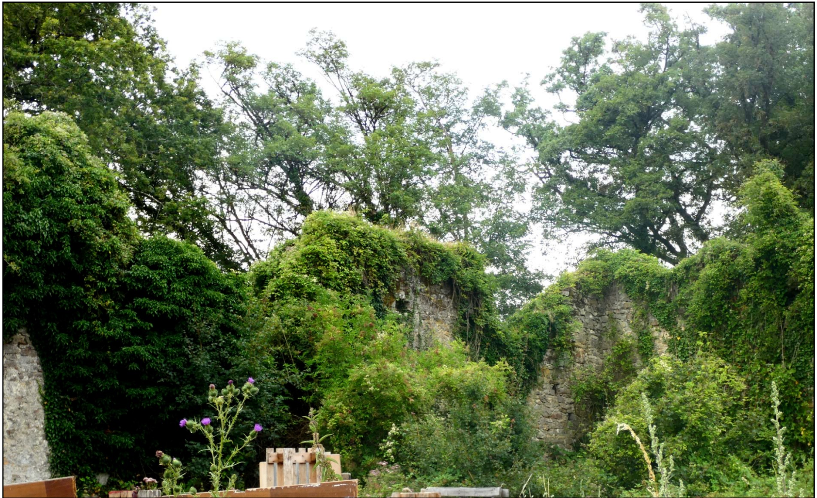
Ci-dessus : vue du mur sud et sud-est de la basse cour du château de Montaiguillon
