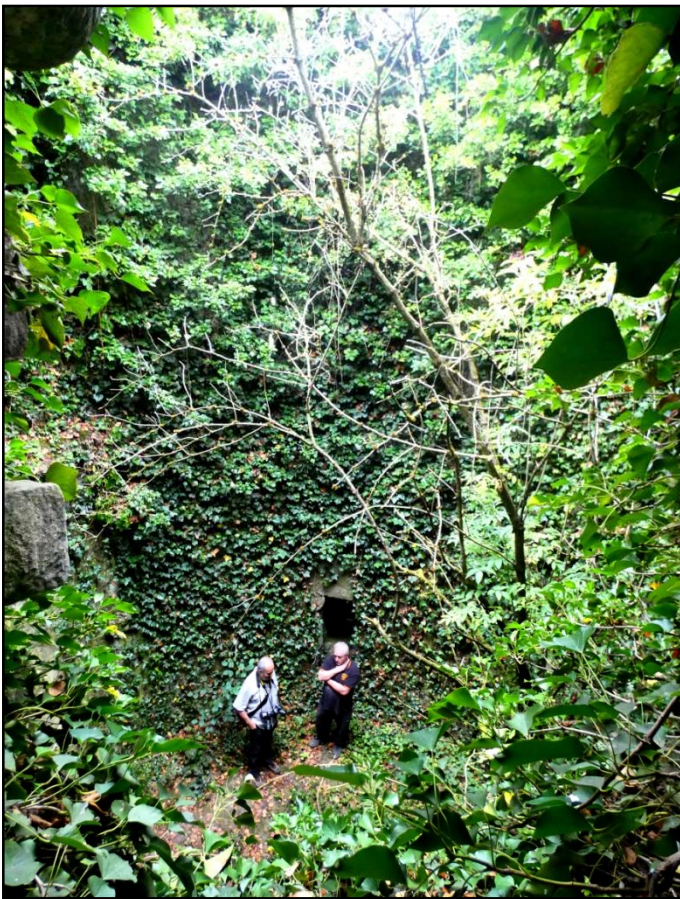
Ci-dessus : vue de la partie inférieure de la tour depuis la partie haute de cette dernière
