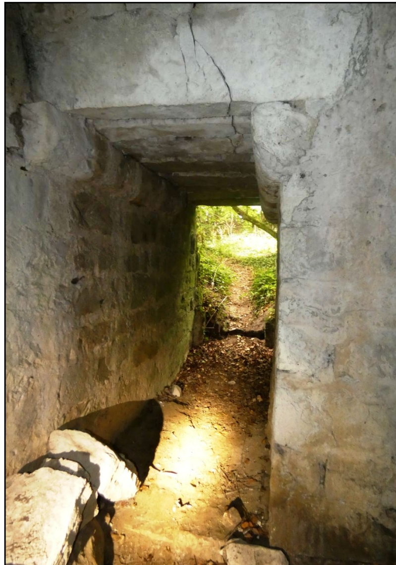
Ci-dessus : Vue du second accès à la première salle souterraine de Montaiguillon
