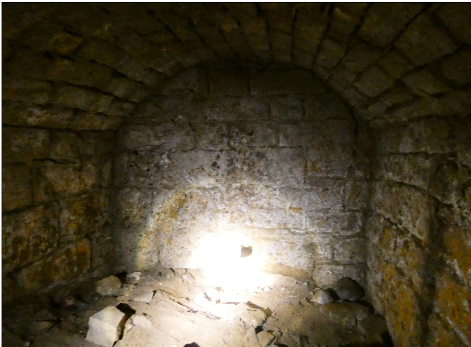
Ci-dessus : côté droit de la seconde salle souterraine. Y est aménagé une seconde «alvéole»
