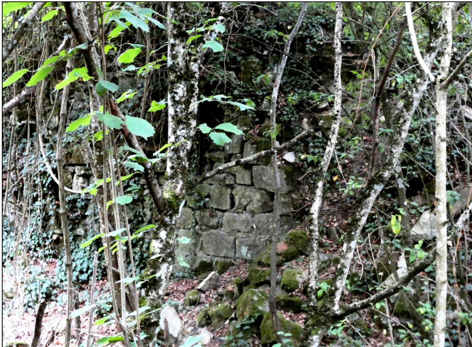
Ci-dessus : Appareillage de blocs de grés de l'une des murailles visibles côté sud de la forteresse de Montaiguillon
