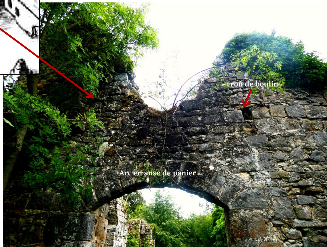
Ci-dessus : Vue de la façade ouest de la chapelle
