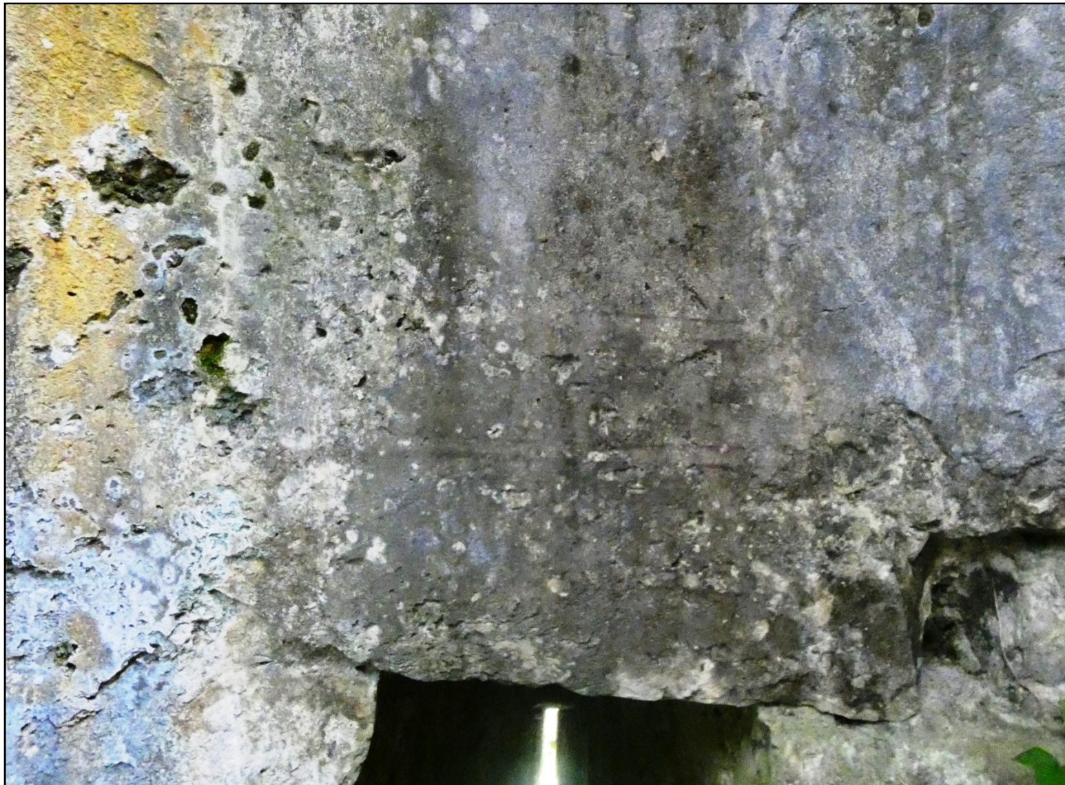
Ci-dessus : Au-dessus de l'archère, décor de faux-appareil en pierre tracé à l'ocre rouge
