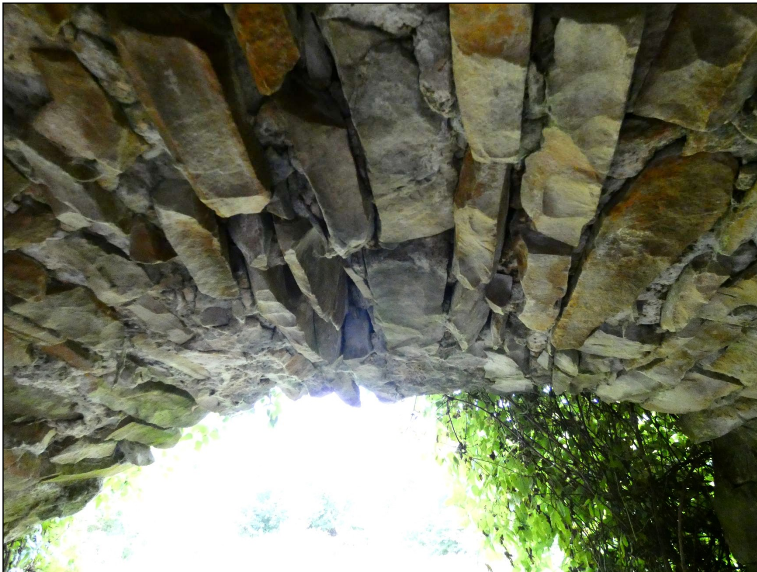
Ci-dessus : Vue de la salle des gardes (?) voûtées en berceau
