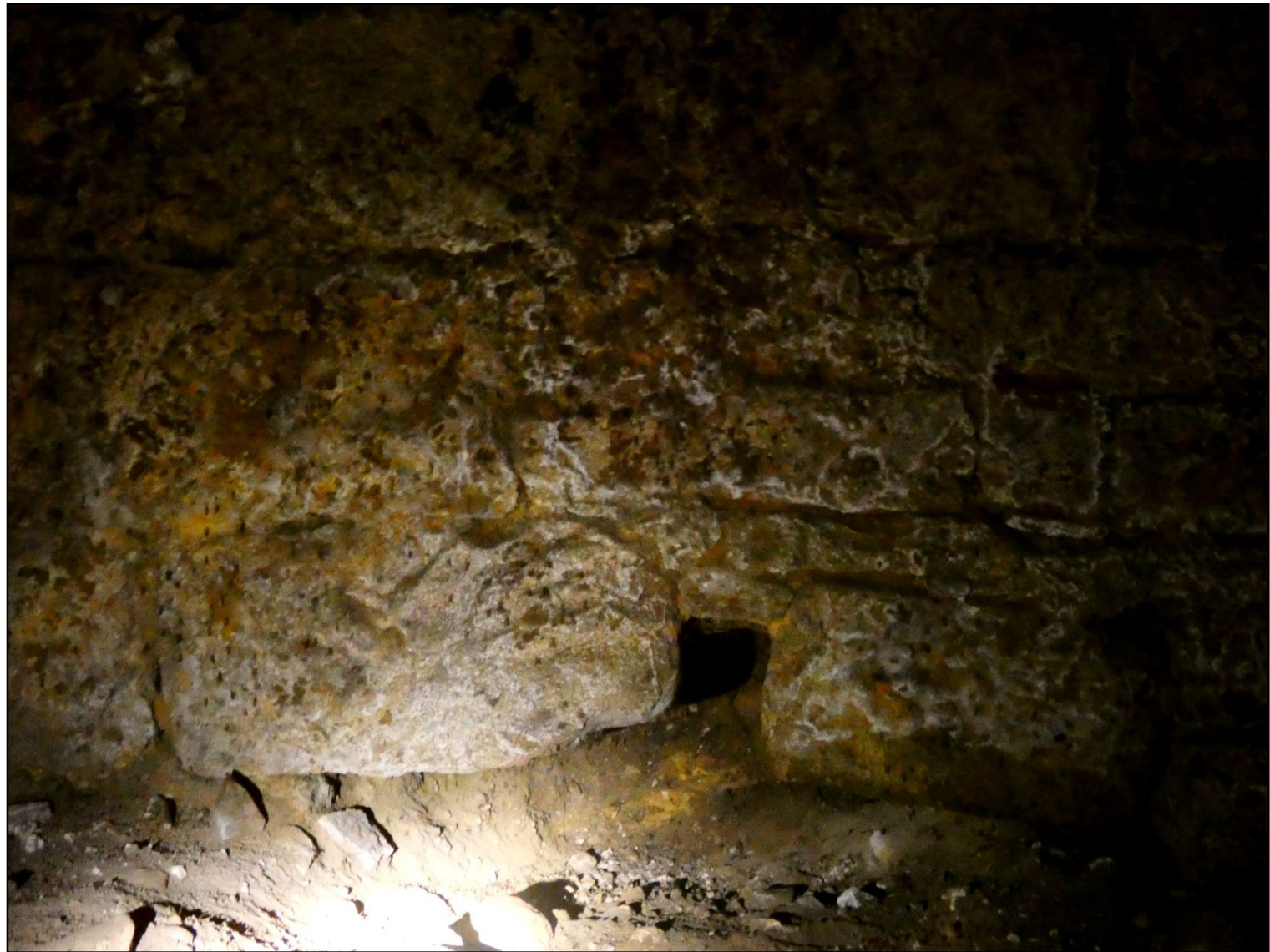
Ci-dessus : Partie basse de la maçonnerie de la seconde «alvéole»
