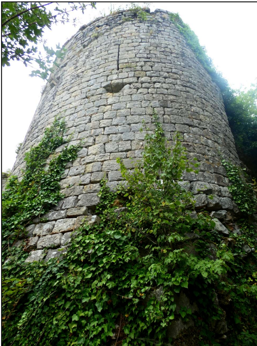
Ci-dessus : Base de la tour nord du châtelet d'entrée
