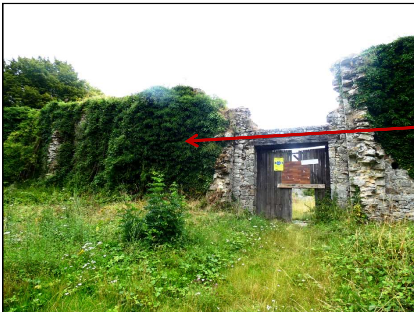
Ci-dessus : vue du mur nord-ouest de la basse-cour
