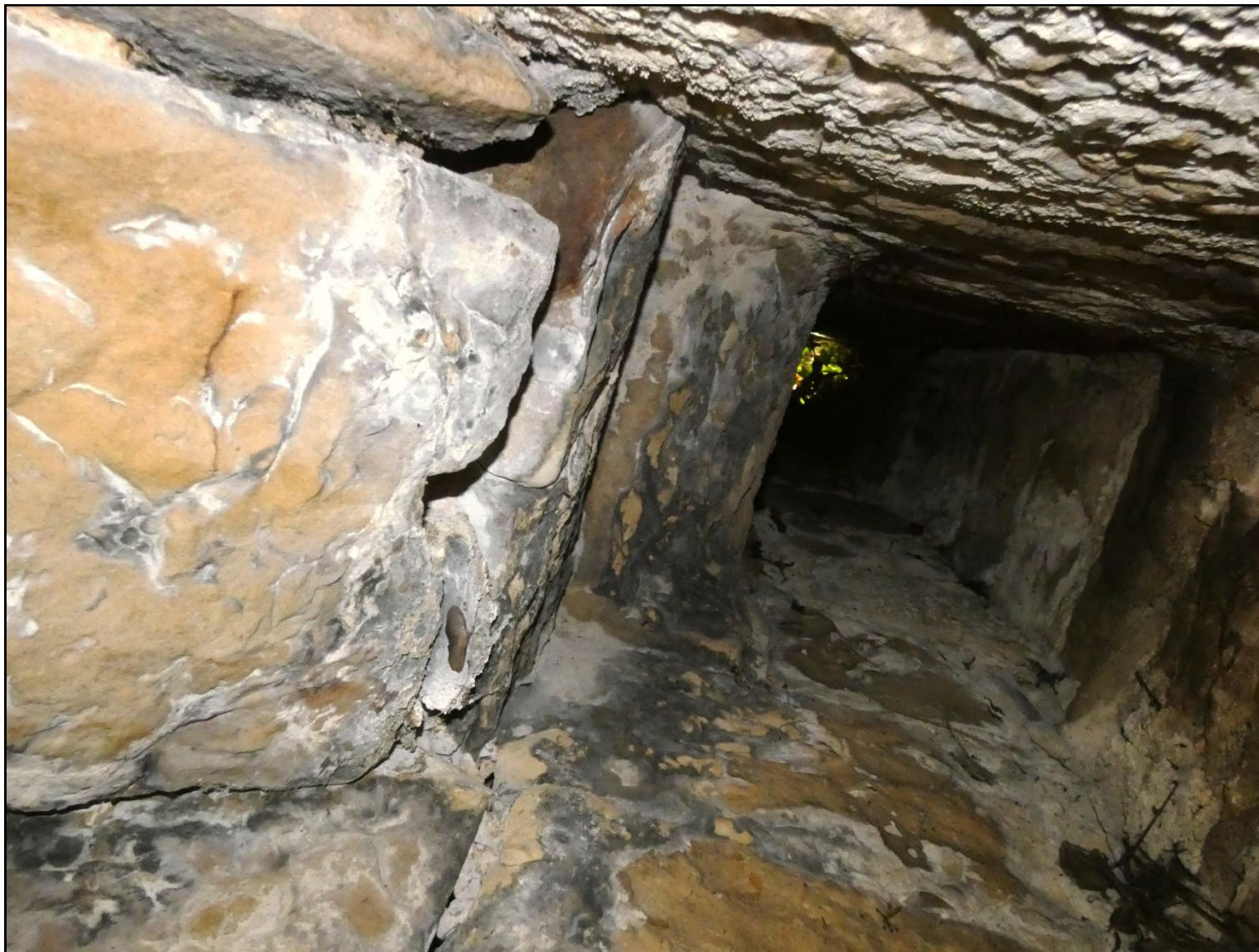
Ci-dessus : Intérieur probable d'un conduit de cheminée ?
