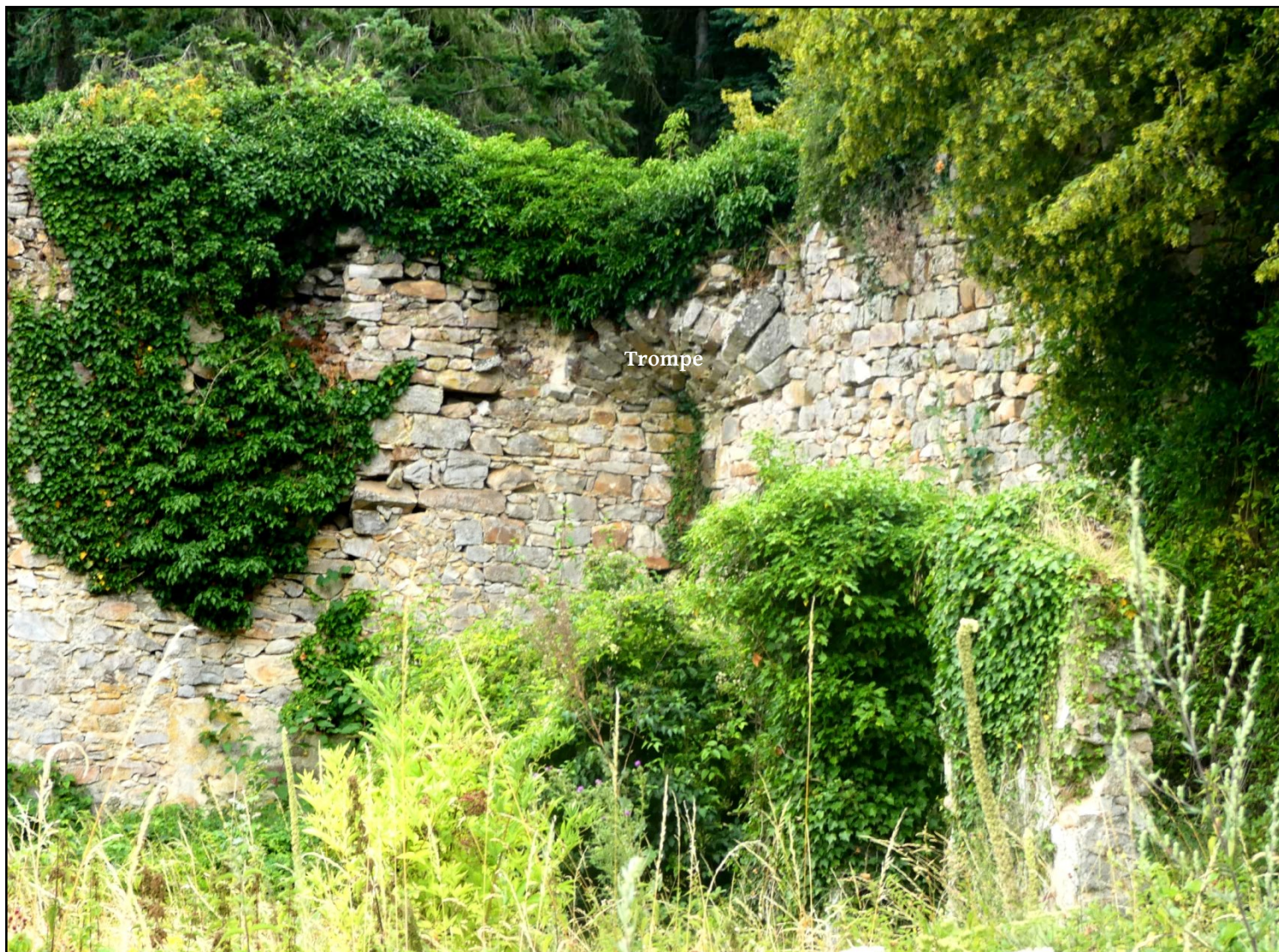
Ci-dessus : Vestige de la tourelle montée sur trompe à l'angle d'une des murailles de la basse cour
