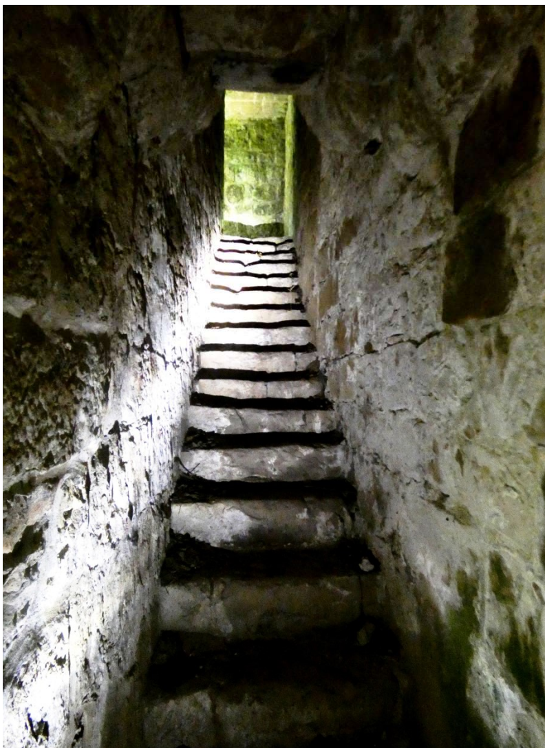
Vue de l'escalier droit donnant accès au niveau où se trouve le pont levis
