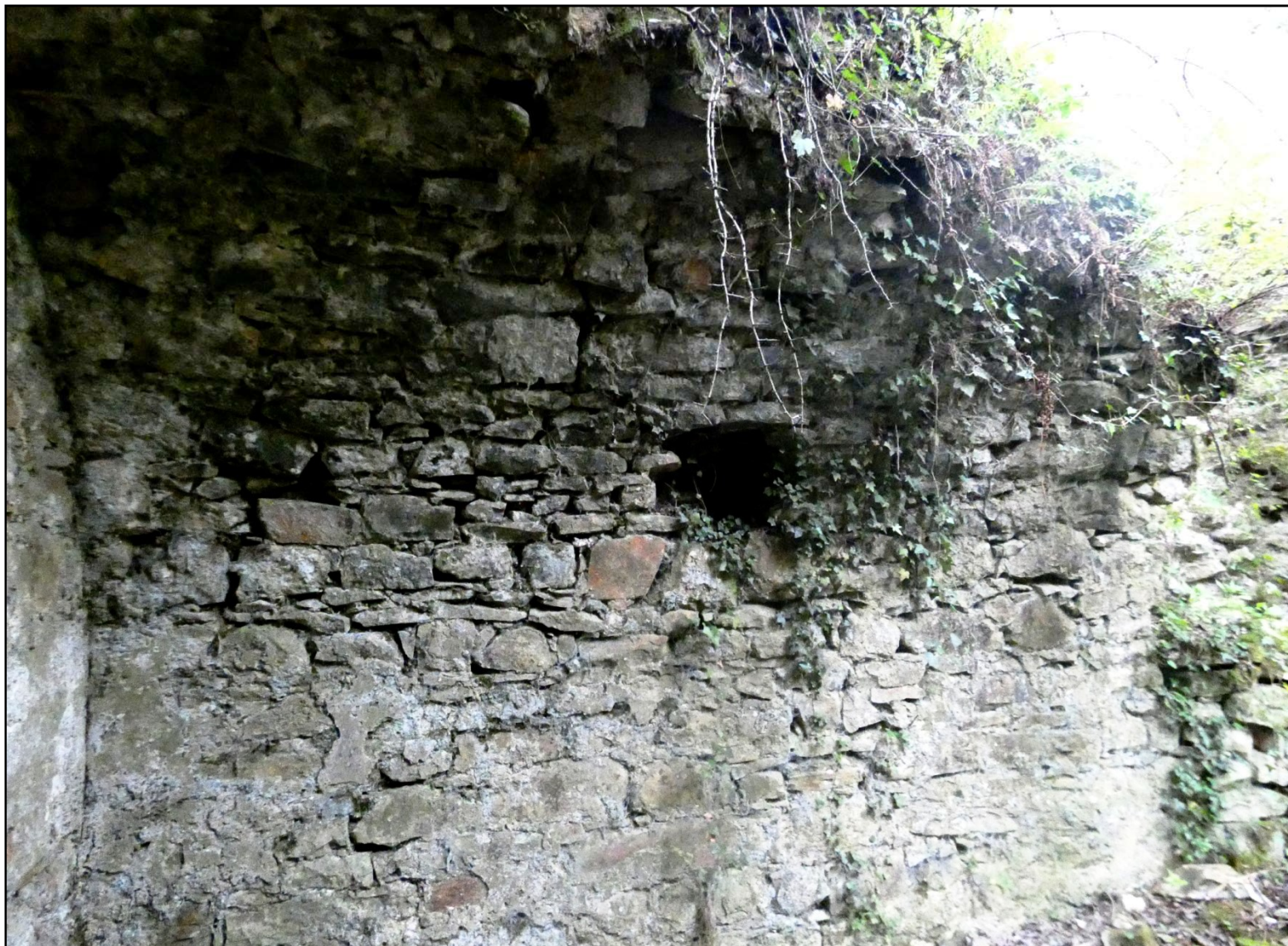
Ci-dessus : Détail de la voûte en berceau couvrant le « corps de garde »
